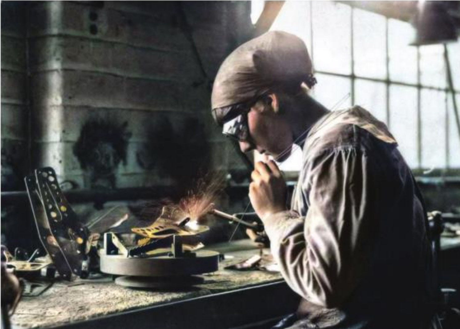
Figura 6 - Fotografia colorata di una ragazza che salda con cannello componenti di telai in un'azienda di aeromobili vicino a Birmingham, Midlands (UK), 1914. Imperial War Museum, University of British Columbia, Library Digitalization Centre.
